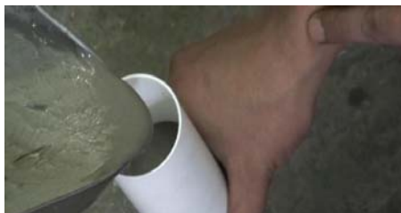
之後，將高強度無收縮水泥砂漿倒入廠商所附之注射器管中。
