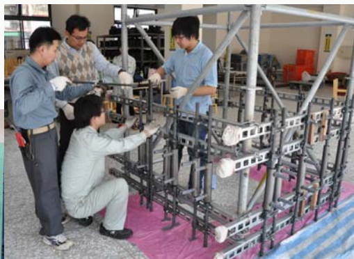
YunTech 工廠測試件固定架 (鋼管施工架組搭)
