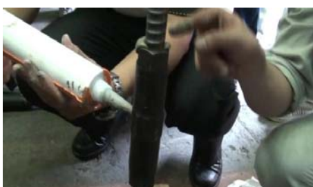
使用注射器將高強度無收縮水泥砂漿注入續接器中至兩旁螺絲滿漿流出即可。
