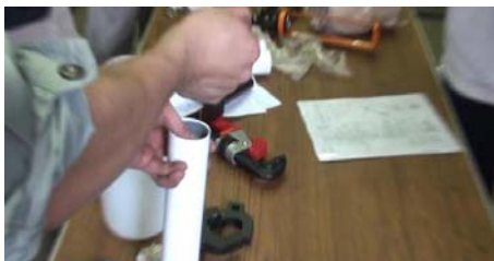
可利用細鐵絲夾於管壁，以利塞上蓋子時排氣。
