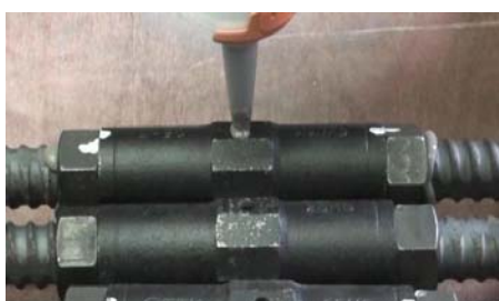
使用注射器將高強度無收縮水泥砂漿注入續接器中至兩旁螺絲滿漿流出即可。
